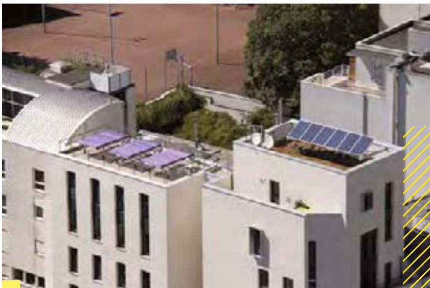
Panneaux solaires sur les toits de Paris.
