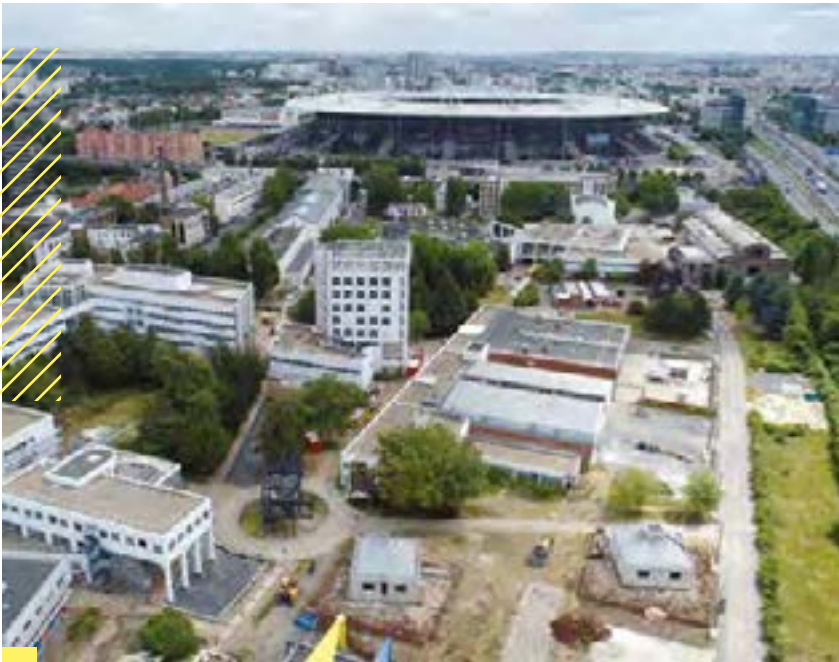
Vue aérienne de la ZAC de la Plaine Saunier, dont la Métropole du Grand Paris assure la maîtrise d'ouvrage.
